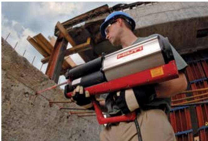
**Figura 37:** Aplicador neumático Hilti HIT-P8000D, adecuado para instalaciones de gran volumen y diámetros de barra grandes
