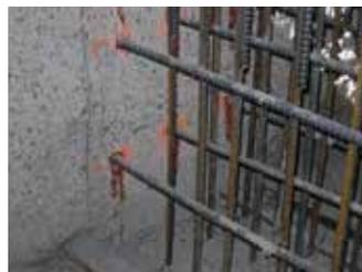
b. Conexión de muro a muro
