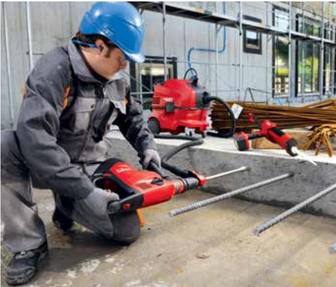
**Figura 25: Perforación con un taladro percutor rotativo Hilti equipado con la tecnología Hilti SafeSet™**
