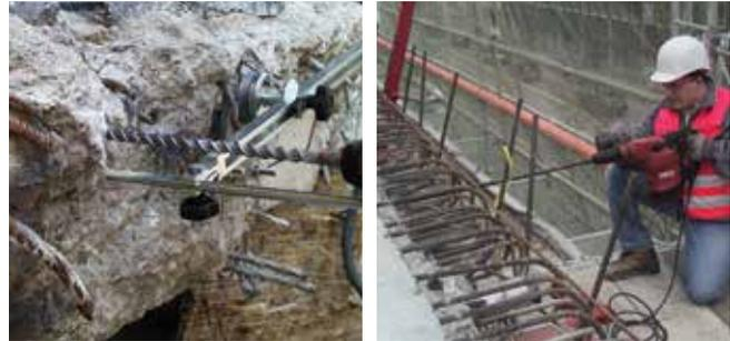
**Figura 24:** Perforación con y sin sistemas de alineación de perforación
