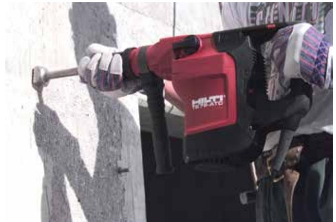
**Figura 22: Rugosidad de una superficie de concreto con un rotomartillo combinado Hilti TE 70**
