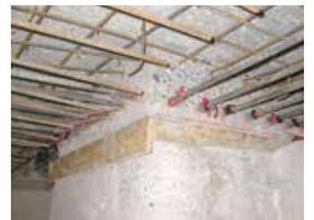
d. Reforzamiento de conexión de losa a columna
