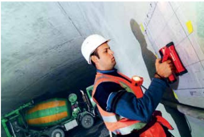
**Figura 21: Uso de un escáner Ferroskan manual Hilti PS 200 para localizar y asignar el refuerzo existente antes de comenzar la perforación**
