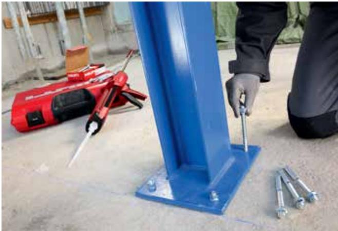
**Figura 1: Instalación de anclaje adhesivo (con Hilti HIT-HY 200 y varilla HIT-Z)**
