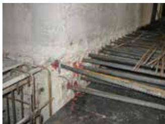
a. Conexión de losa a muro
