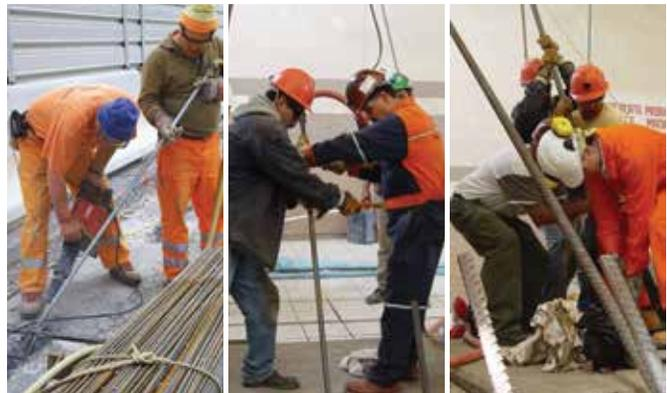
**Figura 38:** Instalación de barras de diámetro grande
