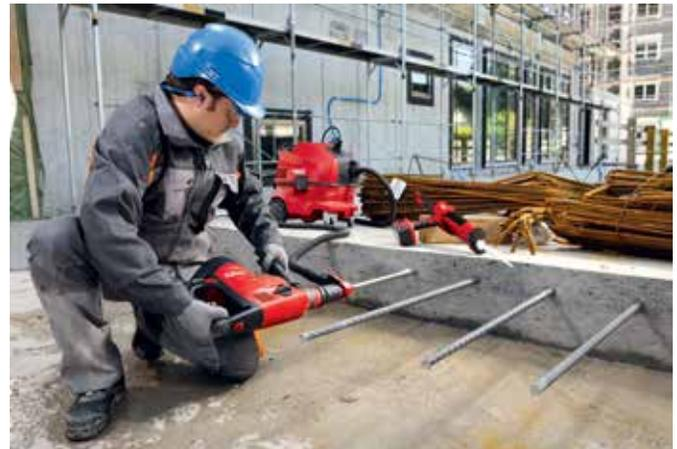
**Figura 2: Inyección de adhesivo Hilti HIT en un orificio perforado con el dispensador a batería Hilti HDE 500-A22 para facilitar la instalación de barras de refuerzo post-instaladas**
