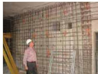
c. Pared de concreto proyectado de recubrimiento
