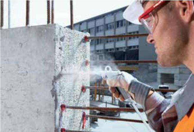
**Figura 33:** Limpieza de un orificio con un soplador de aire comprimido
